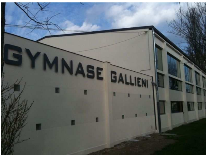
Le gymnase Gallieni après rénovation
